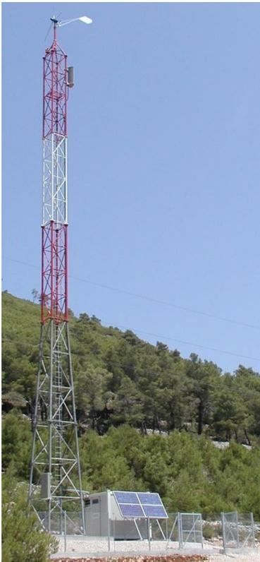
*Vjetroturbina i fotonaponske ćelije za opskrbu telekomunikacijske postaje na Korčuli, 2003.*
